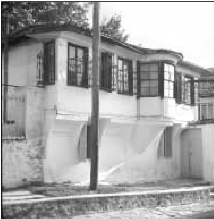
Λαϊκή κατοικία σε βορειοθρακικά πρότυπα, στην συνοικία της Μητρόπολης. Χαρακτηριστικό είναι το κυλινδρικό κεντρικό σαχνισί.
