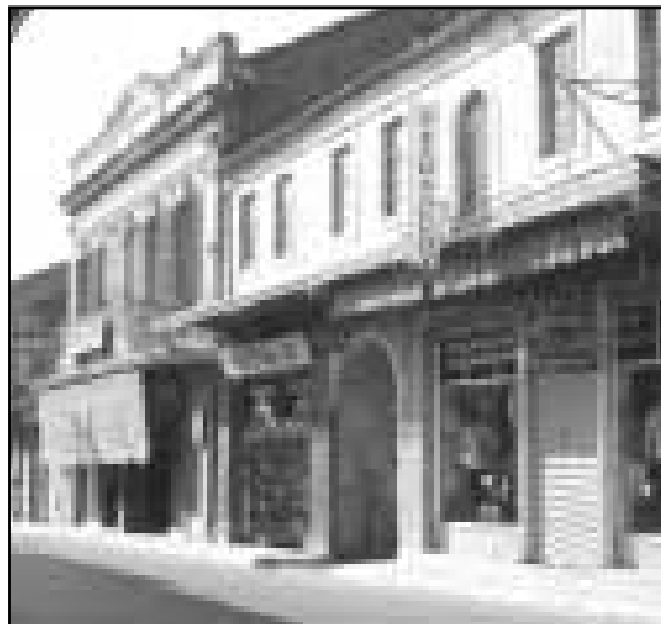
Συγκρότημα καταστημάτων και χάνι στην όδό Καραολή.
