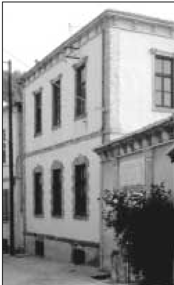
Τό Νηπιαγωγεῖο Στάλιου, κτισμένο τό 1881 σέ ὕψος νεοαναγεννησιακό.
